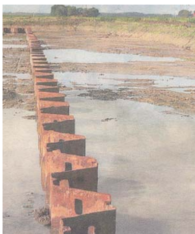
De opgravingsplek aan de N23.
